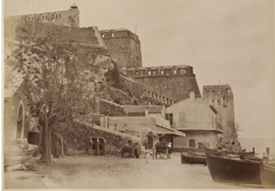
Mers-el-Kébir, village sous le fort vers 1886
